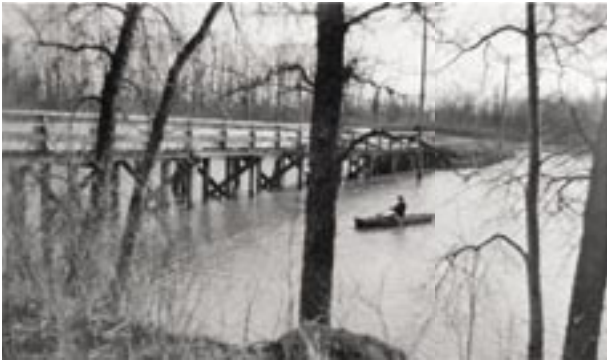
Bridge at foot of rue Campeau 1916 / Pont au pied de la rue Campeau
